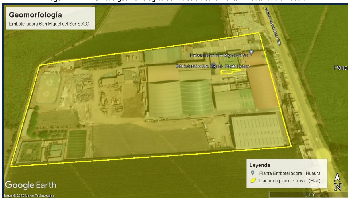
Imagen N° IV - 2: Unidad geomorfológica donde se ubica la Planta Embotelladora Huaura
