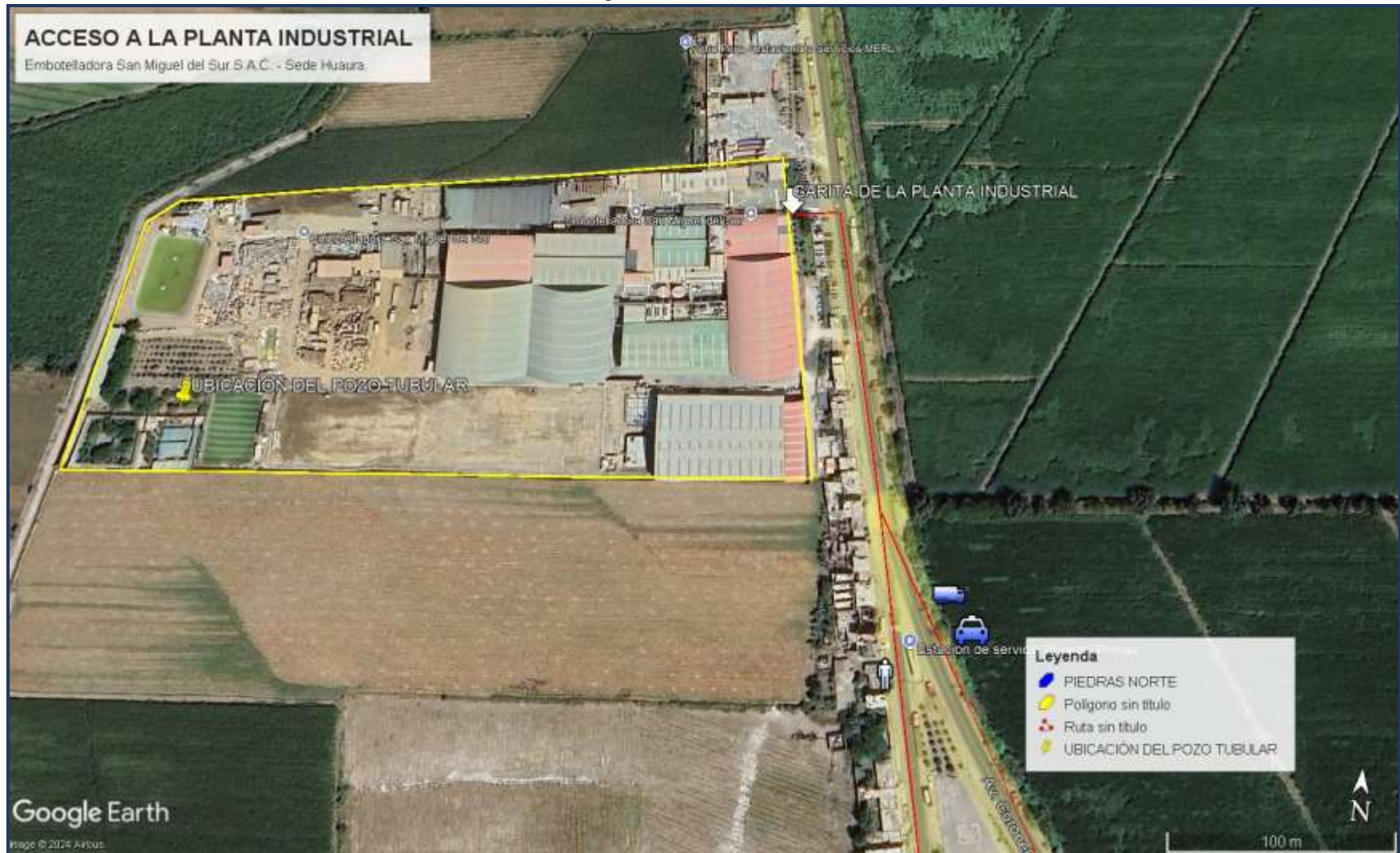
Imagen N° II - 2: Vía de Acceso
