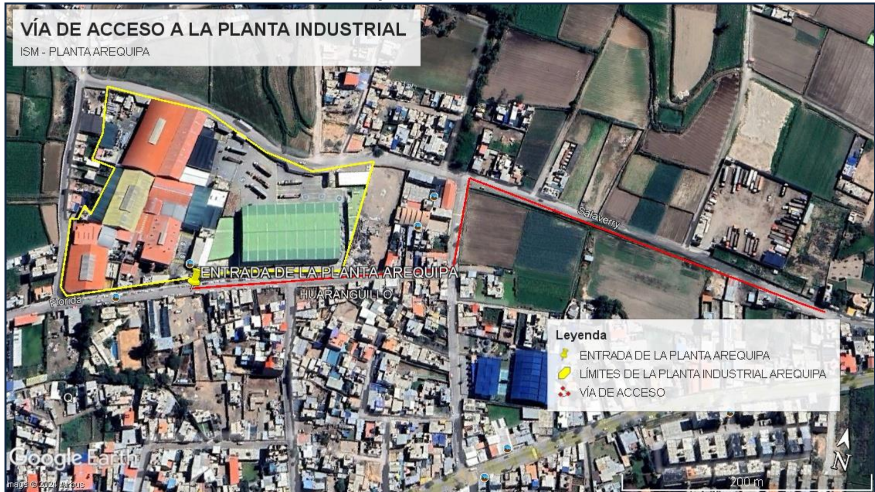
Imagen N° II - 2: Vía de Acceso
